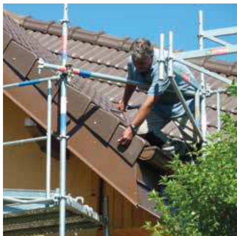
A gauche, réhausse de rive pour accueillir l'épaisseur d'isolant. A droite, le travail de zinguerie en prélaqué.
