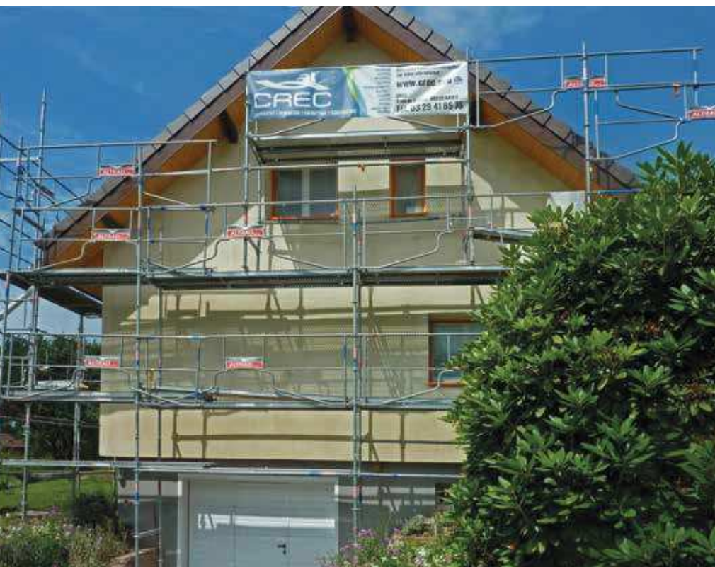
Une idée de la couleur définitive de l'enduit jaune clair final. Ne manque plus que les volets battants électriques à poser pour clore ce beau chantier mené par la coopérative CREC.
