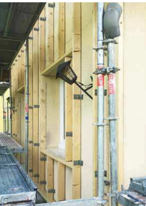
Pose des équerres de l'ossature bois et scellement chimique. Ci-dessous, pose de l'ossature et remplissage en Pavaflex, puis fixation du Pavawall, en partant du bas du mur.
