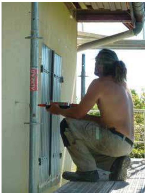
Pose des équerres de l'ossature bois et scellement chimique. Ci-dessous, pose de l'ossature et remplissage en Pavaflex, puis fixation du Pavawall, en partant du bas du mur.
