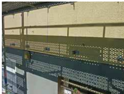
Pose des équerres de l'ossature bois et scellement chimique. Ci-dessous, pose de l'ossature et remplissage en Pavaflex, puis fixation du Pavawall, en partant du bas du mur.
