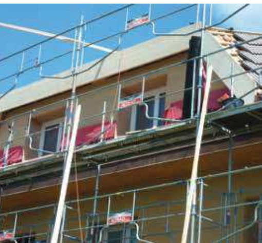
A gauche, réhausse de rive pour accueillir l'épaisseur d'isolant. A droite, le travail de zinguerie en prélaqué.
