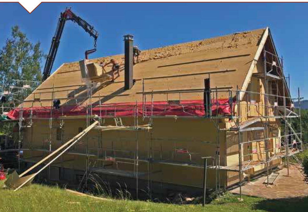
Même traitement de la toiture avec 120 mm de Pavatherm Combi et 52 mm de fibre de bois Isolair, jouant le rôle de pare-pluie.
