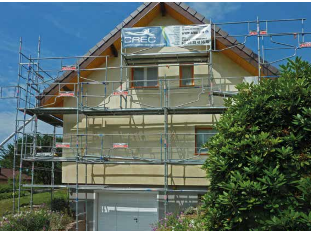
Une idée de la couleur définitive de l'enduit jaune clair final. Ne manque plus que les volets battants électriques à poser pour clore ce beau chantier mené par la coopérative CREC.
