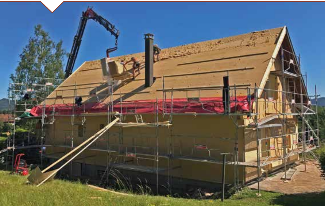
Même traitement de la toiture avec 120 mm de Pavatherm Combi et 52 mm de fibre de bois Isolair, jouant le rôle de pare-pluie.
