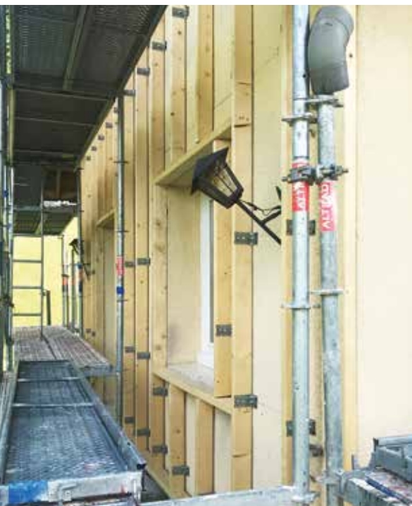
Pose des équerres de l'ossature bois et scellement chimique. Ci-dessous, pose de l'ossature et remplissage en Pavaflex, puis fixation du Pavawall, en partant du bas du mur.
