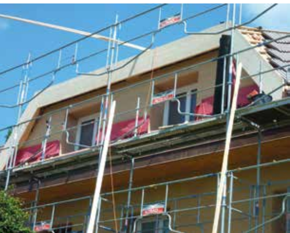
A gauche, réhausse de rive pour accueillir l'épaisseur d'isolant. A droite, le travail de zinguerie en prélaqué.
